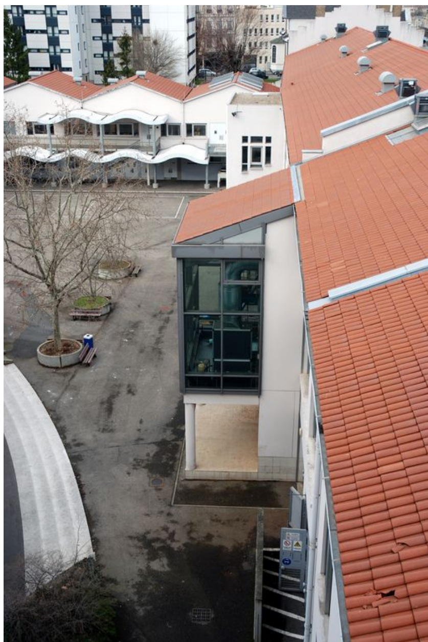
Bâtiment B : vue de l'avancée accueillant la machine à fabriquer les sacs plastiques
