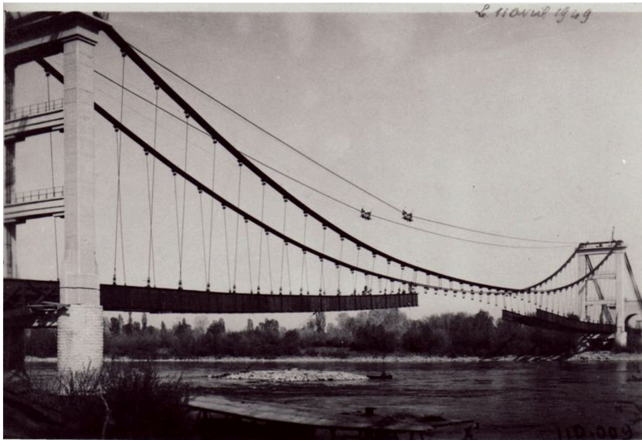
[Reconstruction du pont. Mise en place des poutrelles] / Fives-Lille (Givors) phot., [11 avril 1949]. 1 fotogr. pos. : n. et b. (Lyon, Inventaire général)
