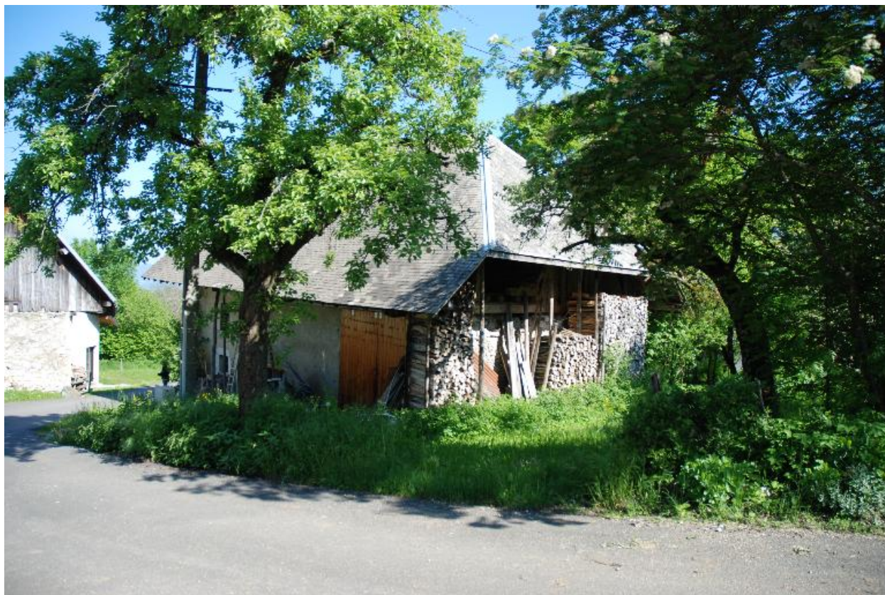
Vue depuis le sud-est.
