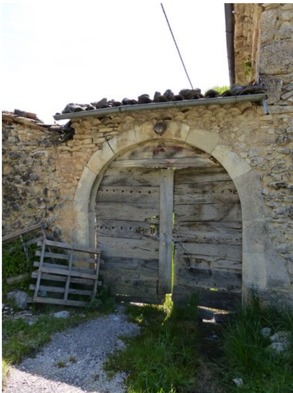
Portail de la cour, vue prise du nord.
