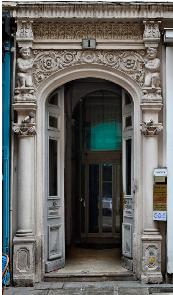
Rue Ferrandière : la porte bâtarde, vue rapprochée
