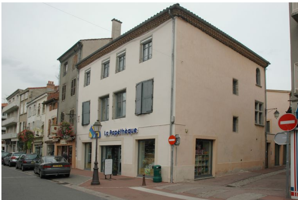
Vue générale, angle rue Tupinerie rue Précomtal.
