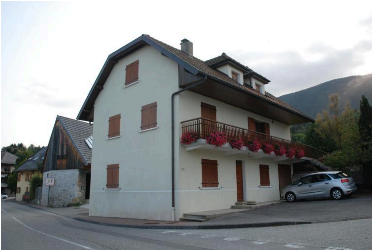
Viuz-Sud, C4 1473. Maison. Vue d'ensemble de trois-quarts avant gauche.
