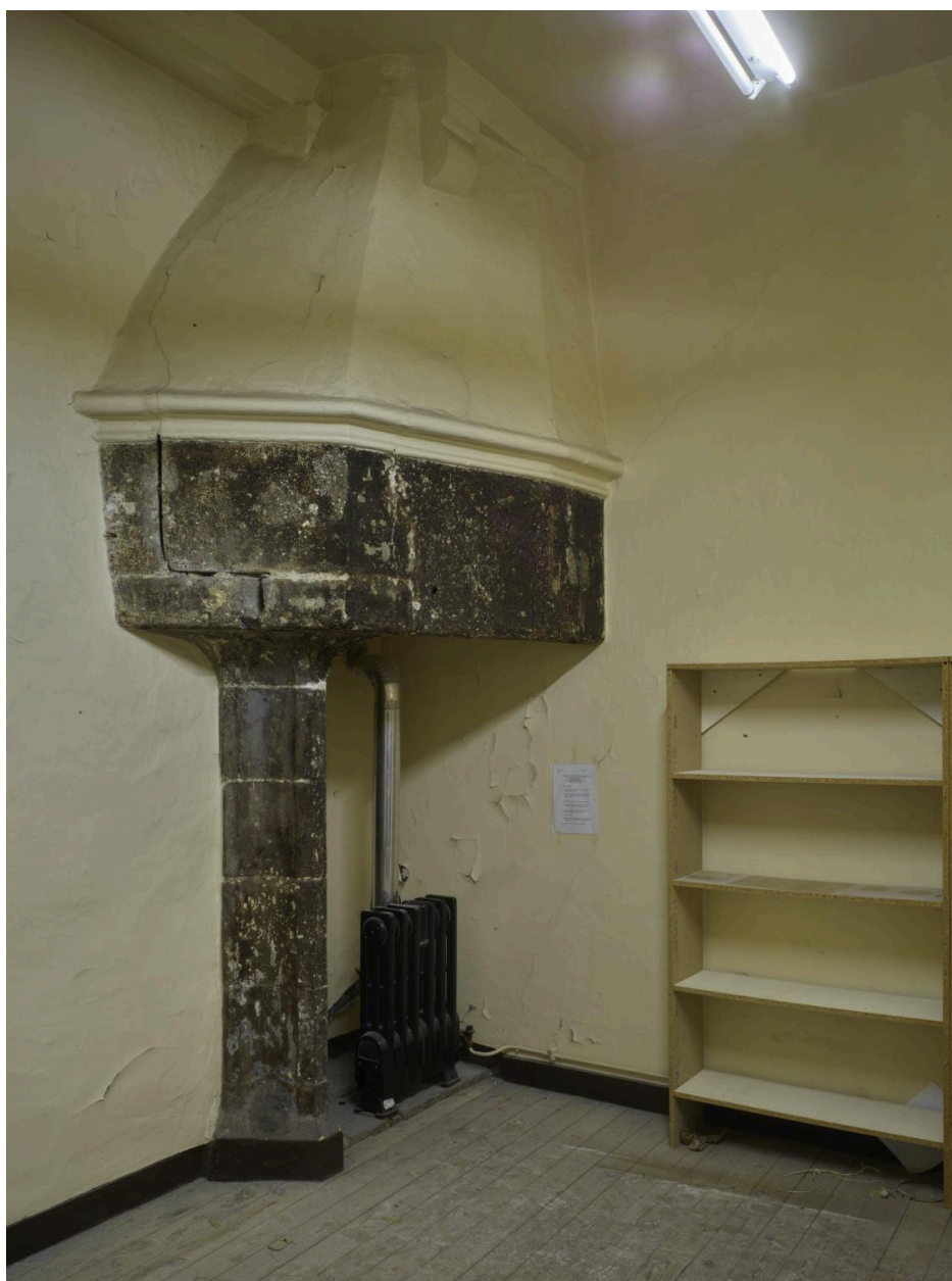
Cheminée du 1er étage
