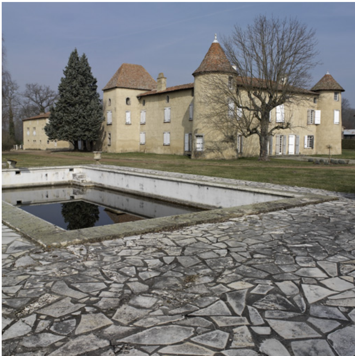
Vue générale du château depuis le sud-ouest.
