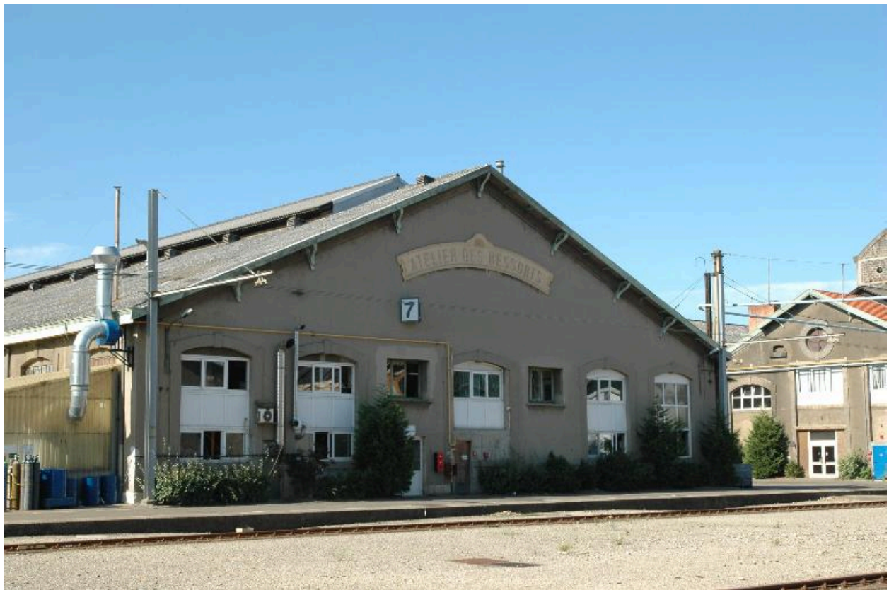
Vue extérieure : façade atelier des ressorts 1882.
