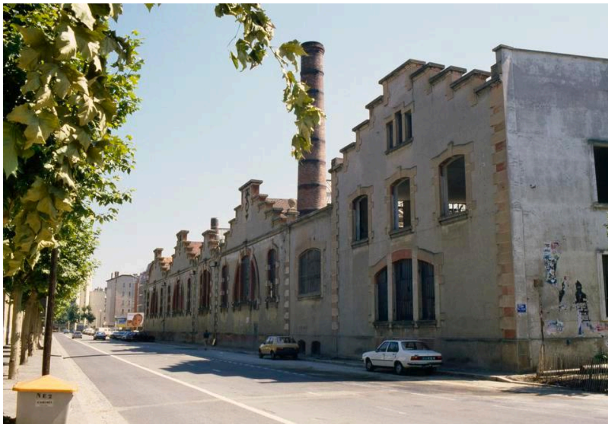
Façade principale en 1985 (avant démolition) (cote : 5613WM030)
