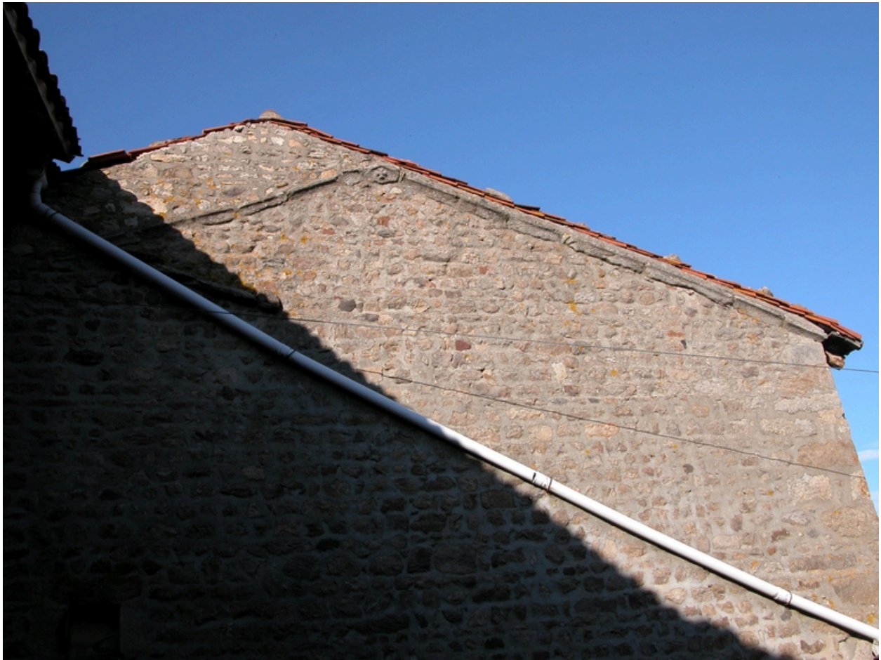
Mur pignon de l'étable.
