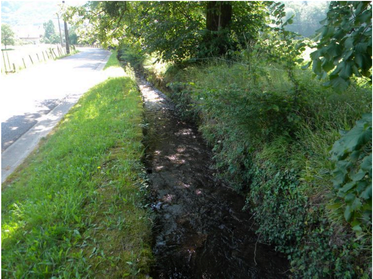
Vue du nant de la Chamossière canalisé en limite avec Doussard.
