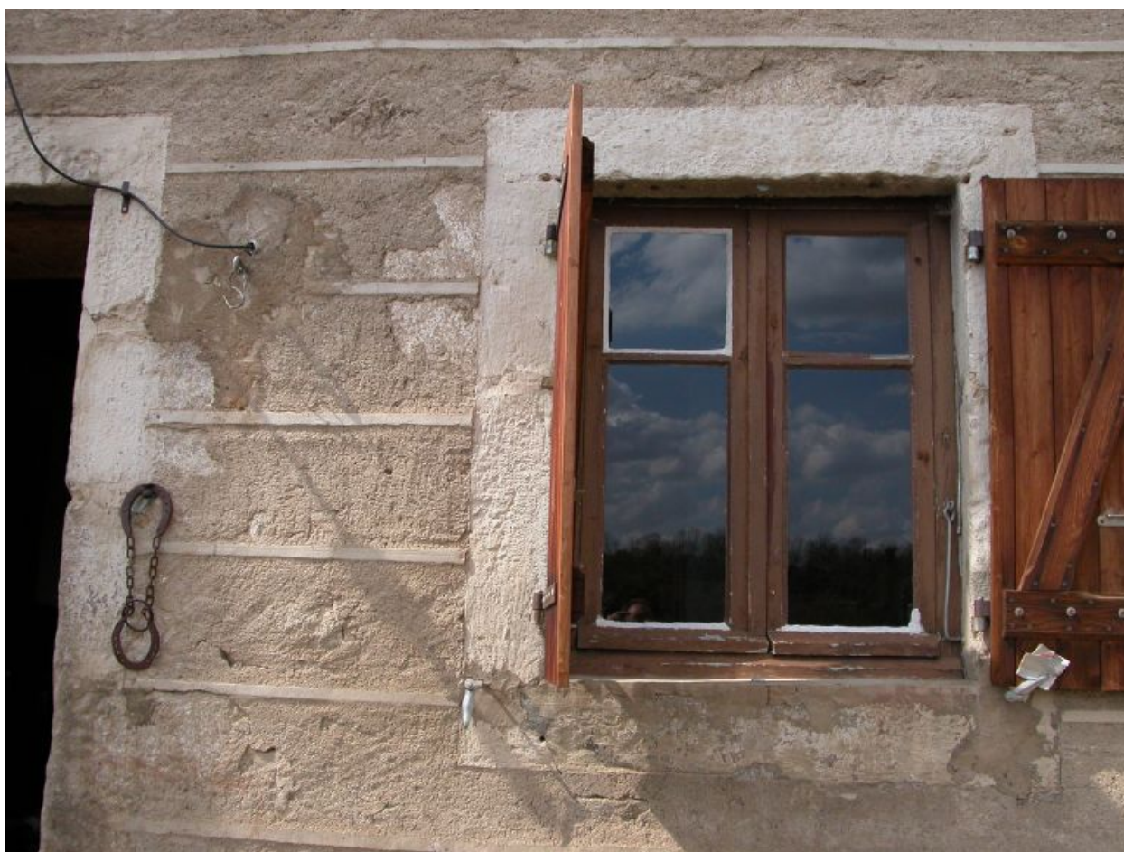
Détail de baies du logis.
