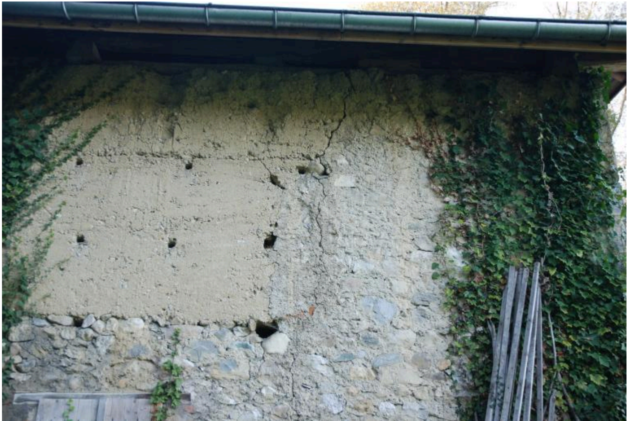
Détail de l'élévation postérieure : pisé et moellon calcaire.
