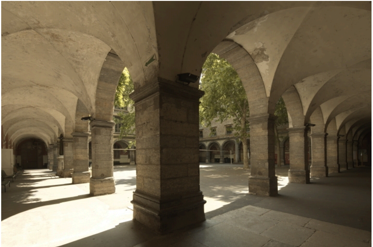
Cour du lycée. Galeries intérieures depuis l'angle nord-est.
