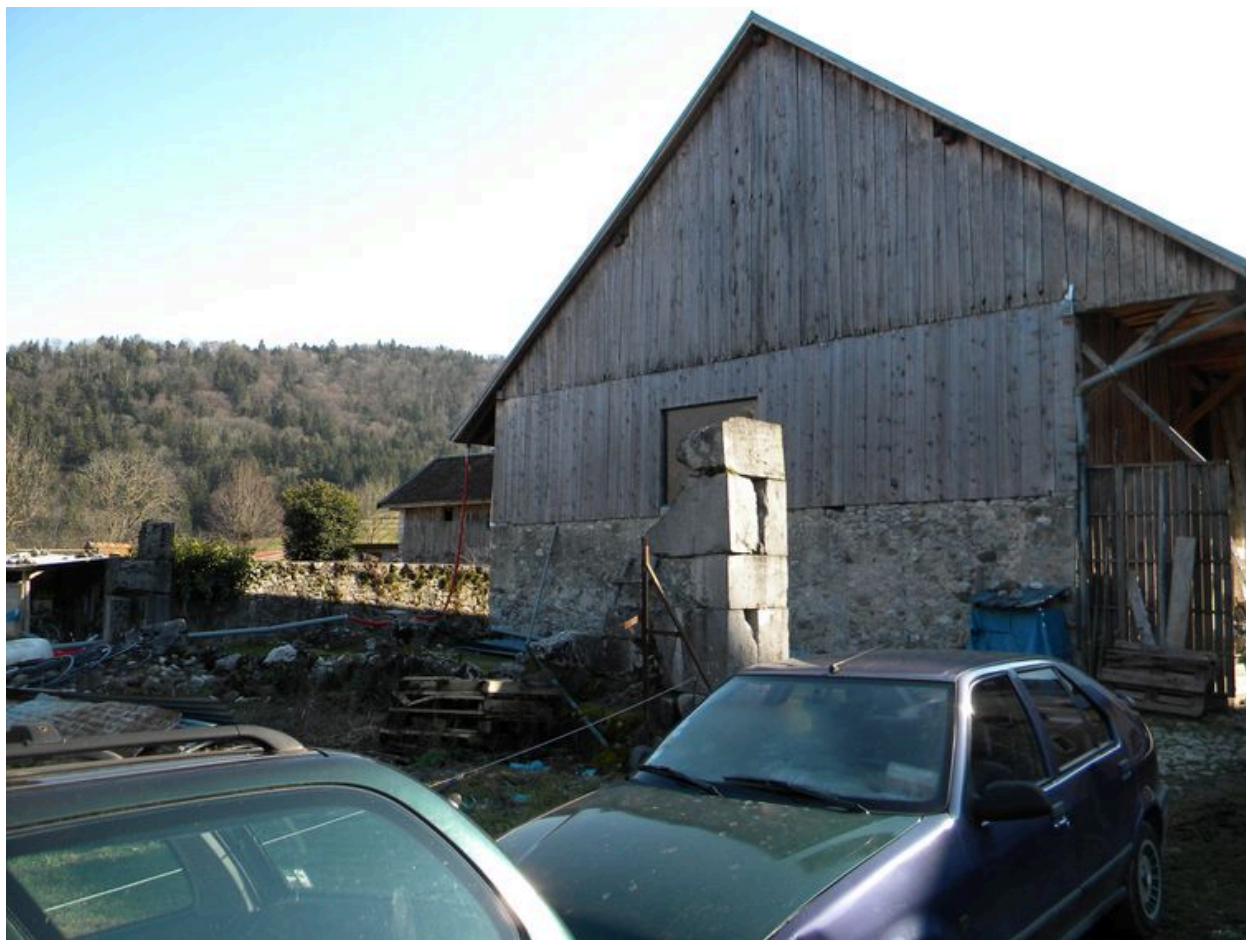
Pignon nord du bâtiment principal.
