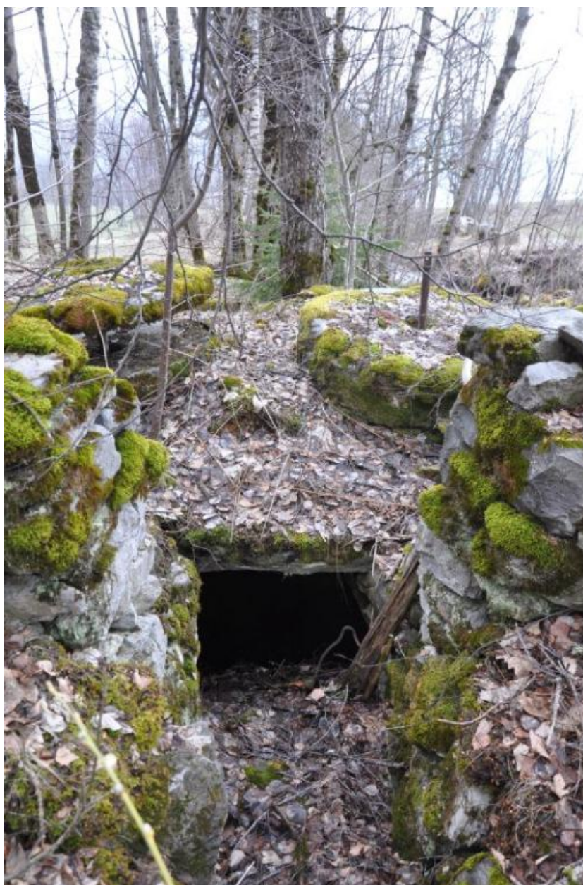
Passage du canal d'amenée sous le bâtiment.
