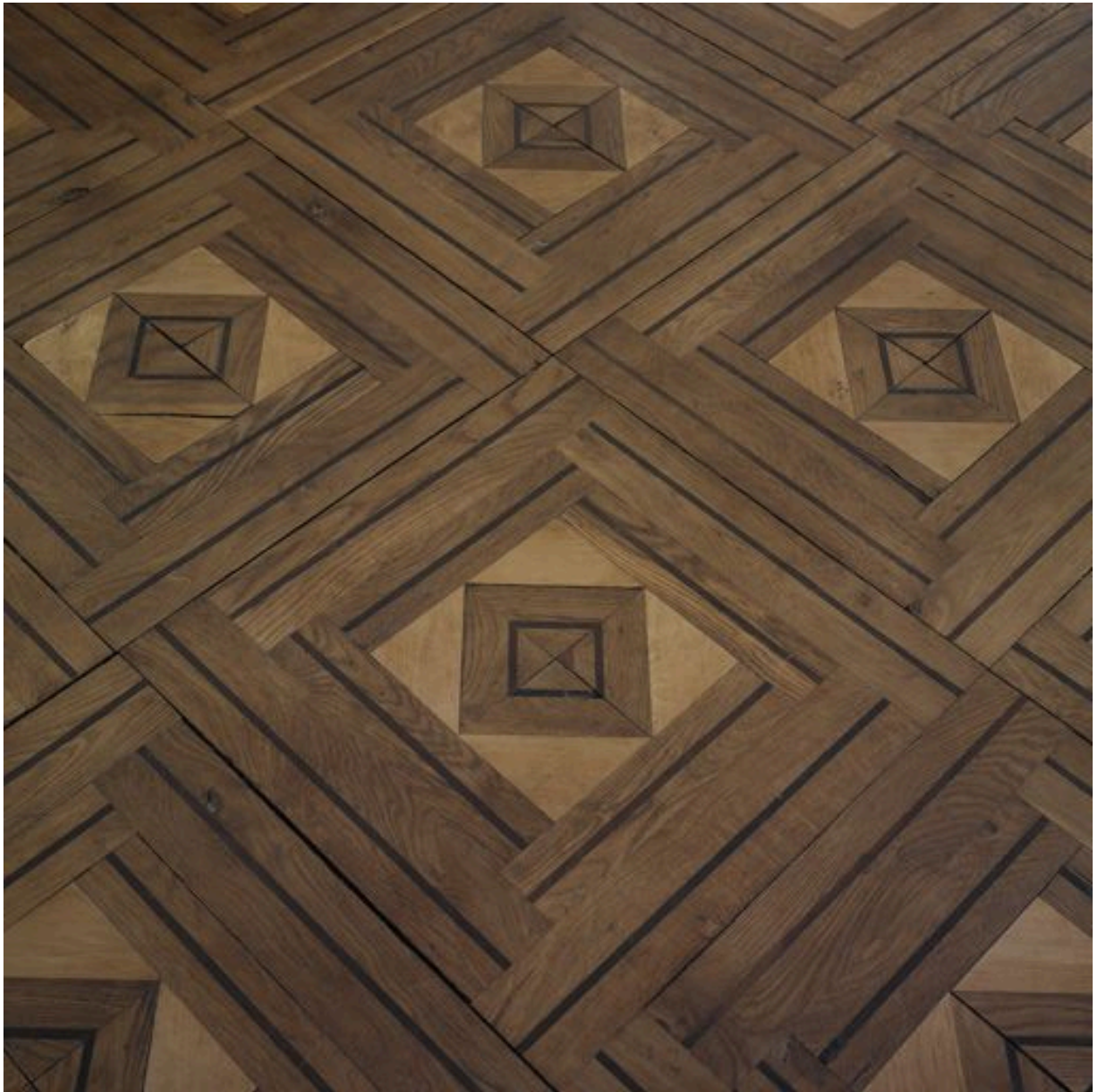
Ancien appartement du curé, grand salon, détail du parquet en marqueterie composé de 3 essences de bois différentes
