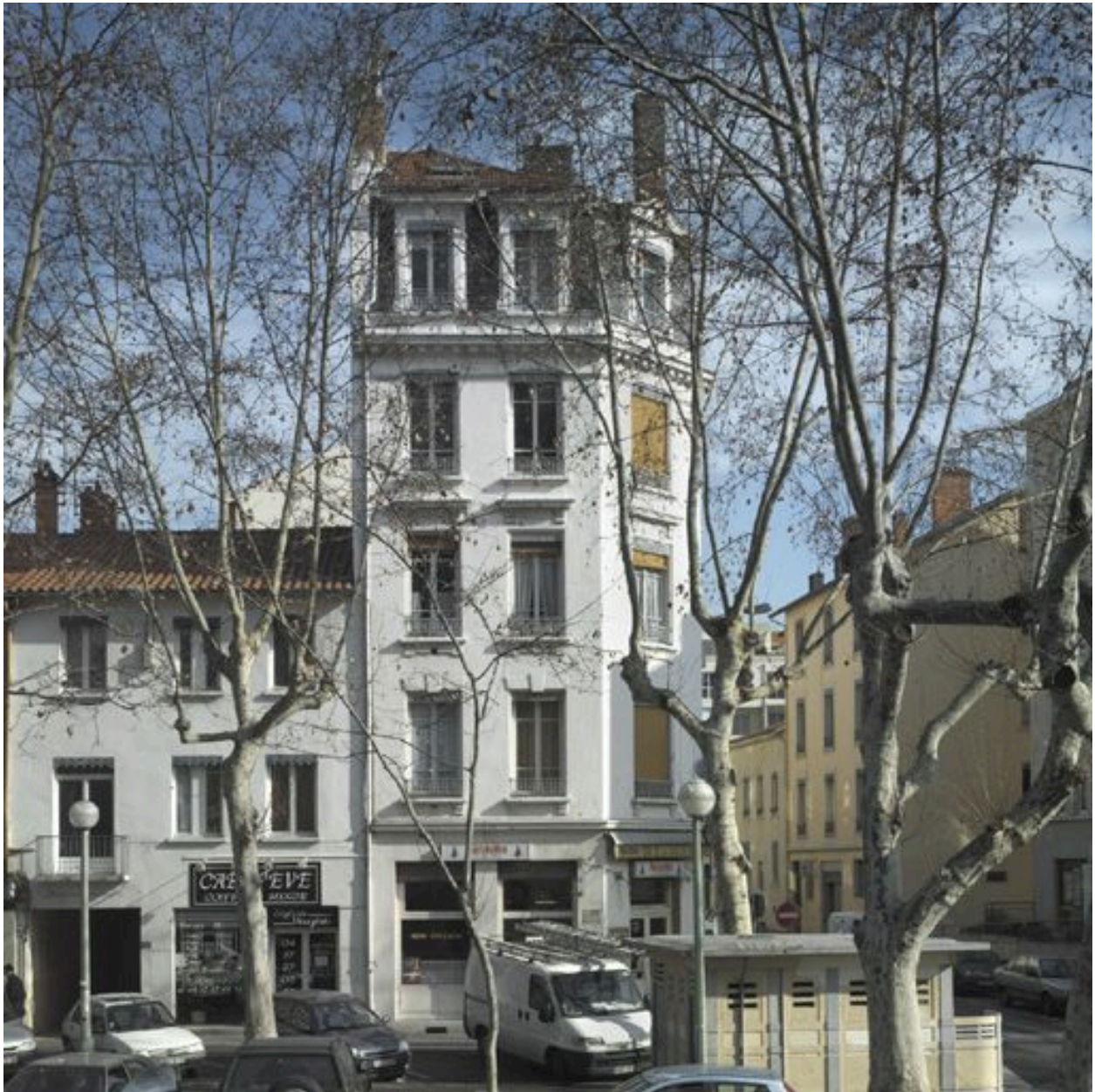
Elévation sur la place Saint-Louis
