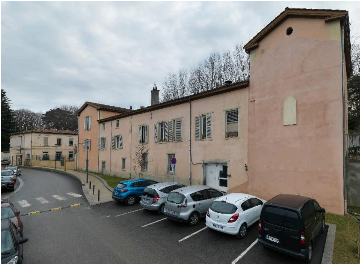
Vue d'ensemble des bâtiments nord, élévation nord (bâtiments administratifs)
