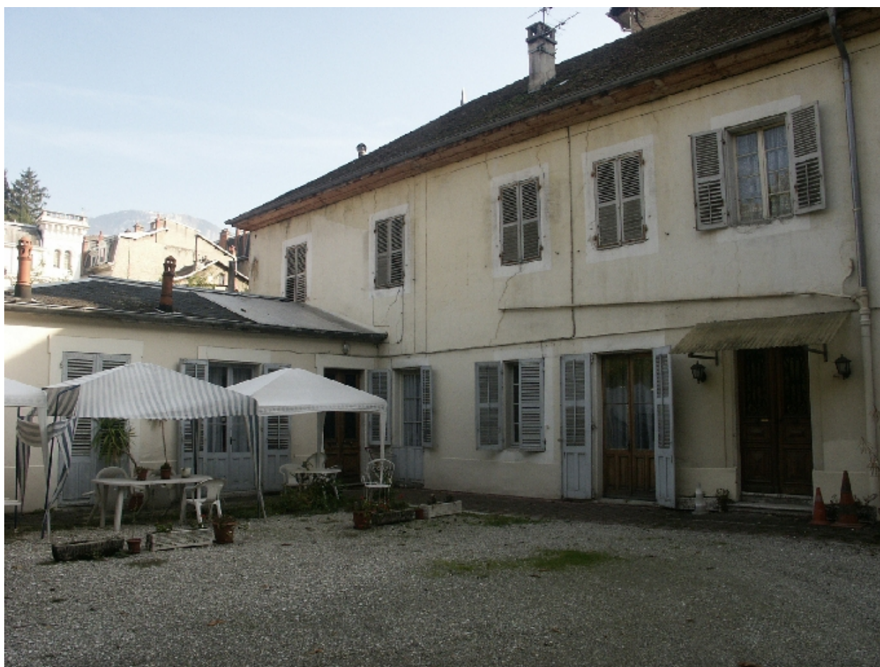
Façade sur cour : partie gauche
