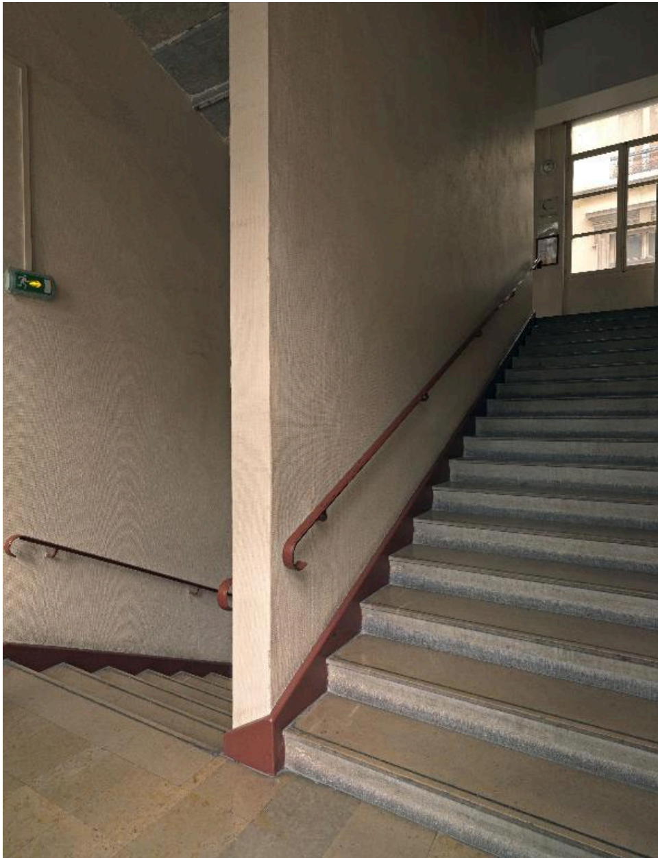
Cour des cuisines, corps de bâtiment nord : escalier C, 3e volée
