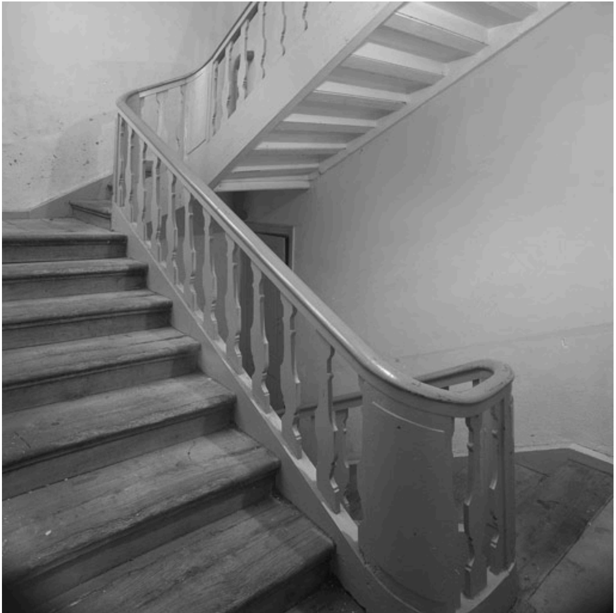
Vue partielle de l'escalier tournant à retours avec jour et rampe en bois découpé.
