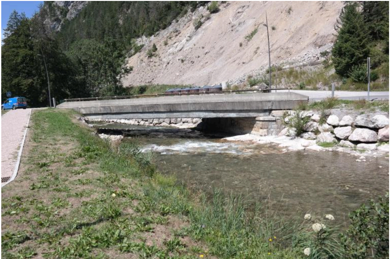
Pont d'Abondance, vue de la face amont
