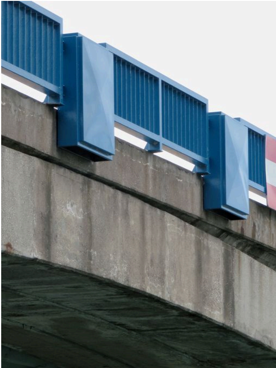
Tablier et parapet, face amont, vue de détail (depuis la rive gauche)
