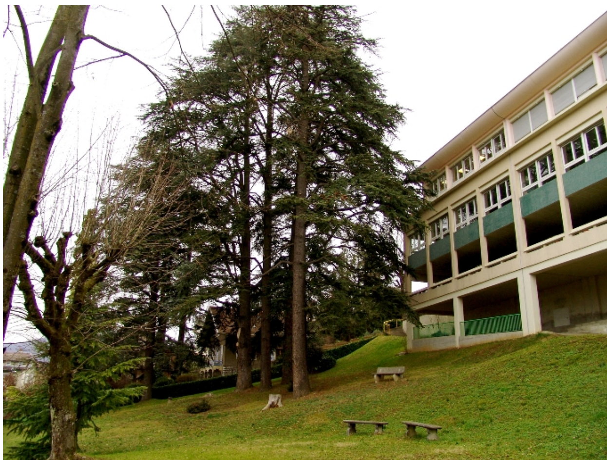
Bâtiment de 1992 : élévation ouest sur jardin
