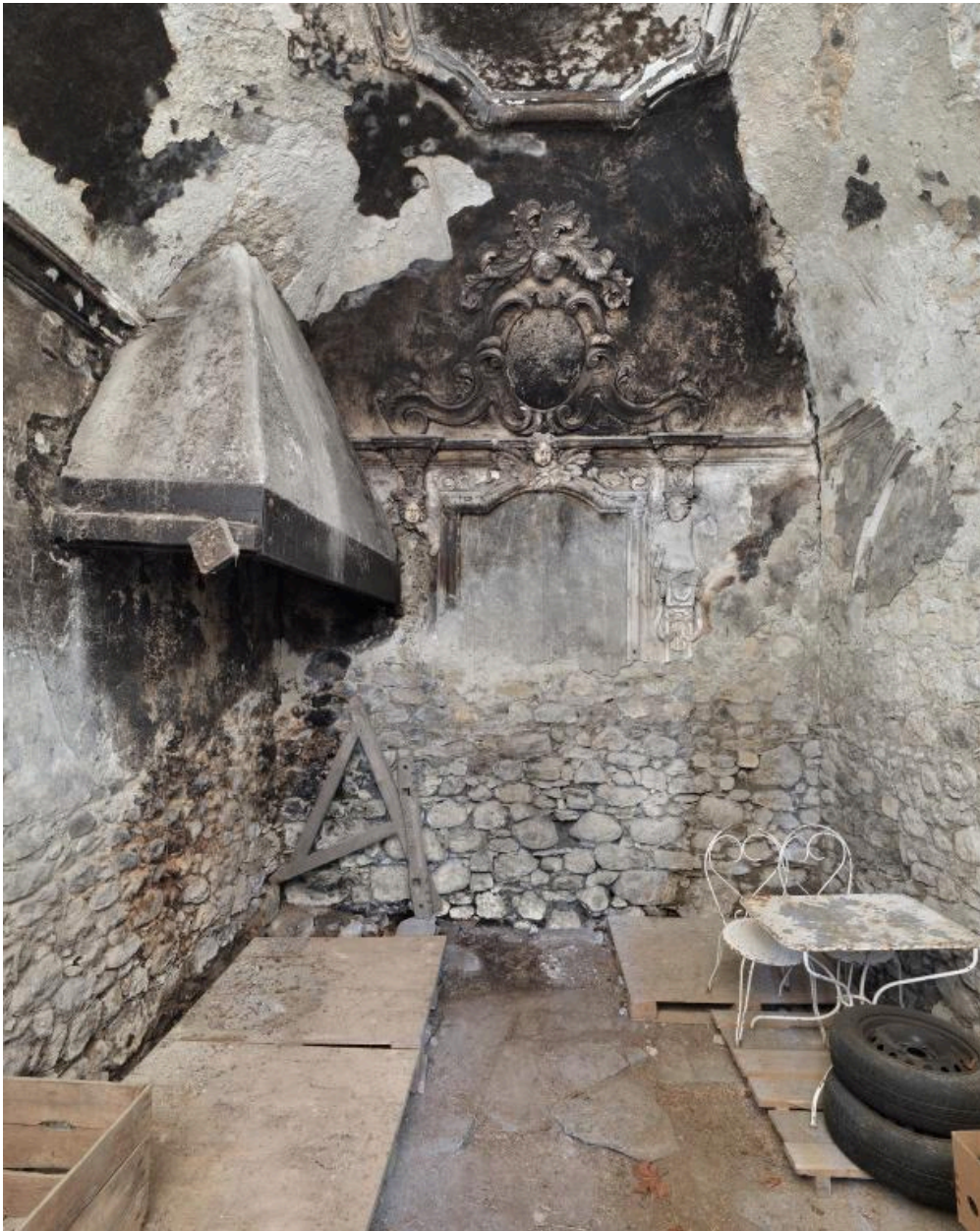
Vue d'ensemble intérieure de l'ancienne chapelle.
