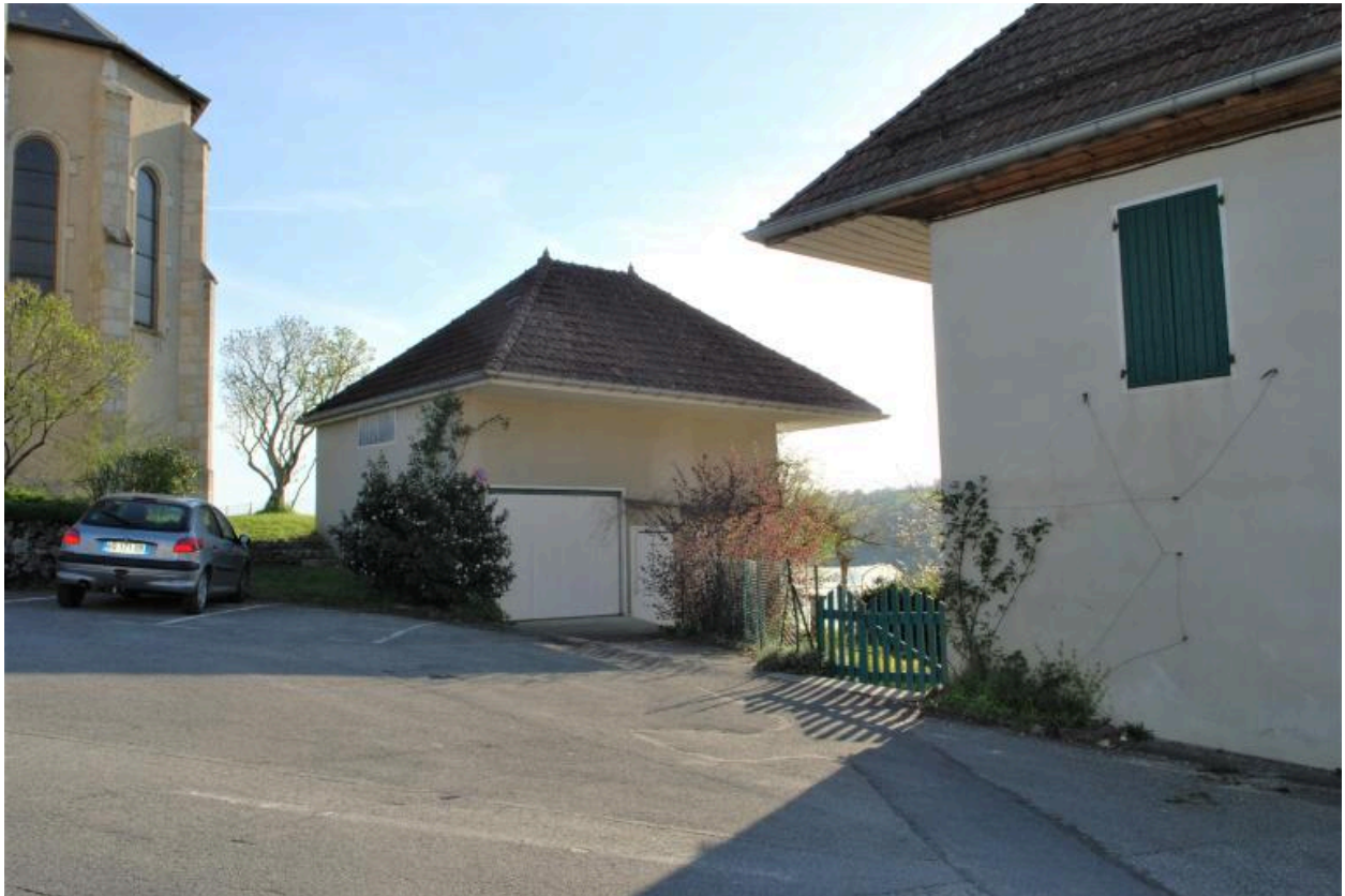
Cusy, B2 83, 86, ferme. Vue d'ensemble de la parcelle 83, dépendance de trois-quarts.
