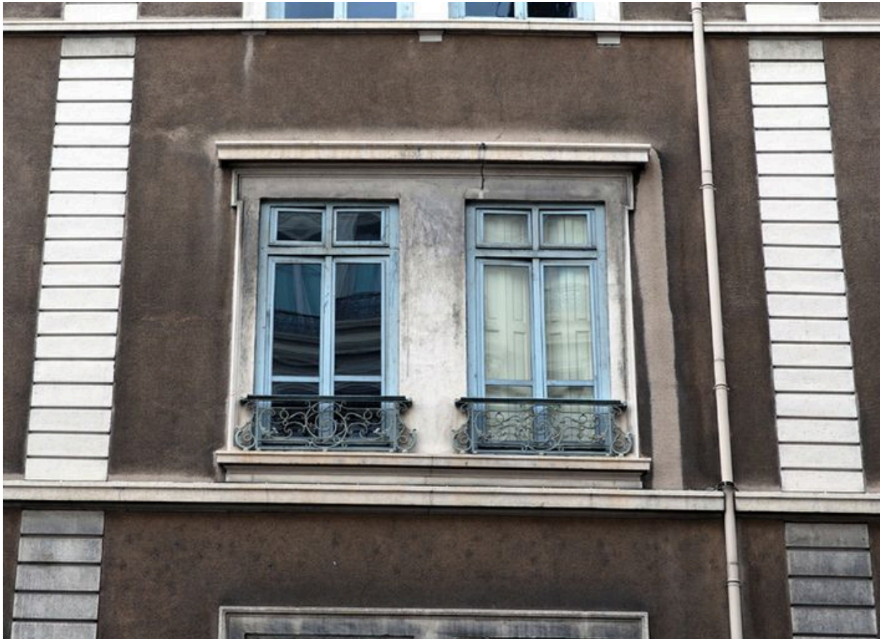
Baies du 1er étage
