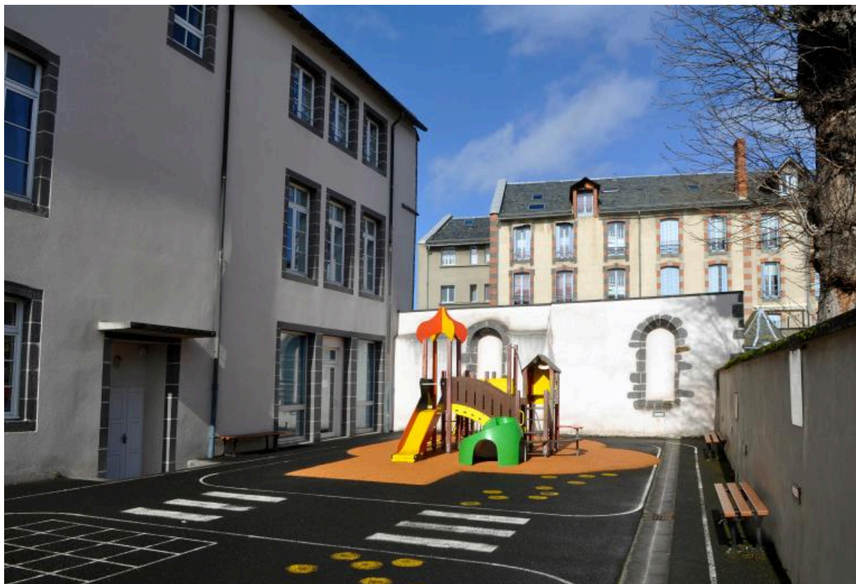
Corps de bâtiment est : élévation postérieure, et cour de récréation, depuis le sud
