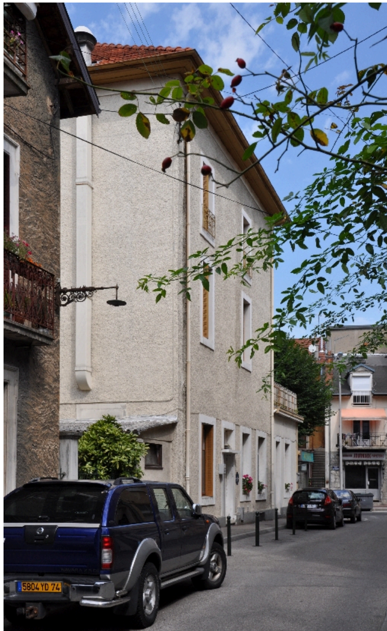
Façade postérieure et latérale
