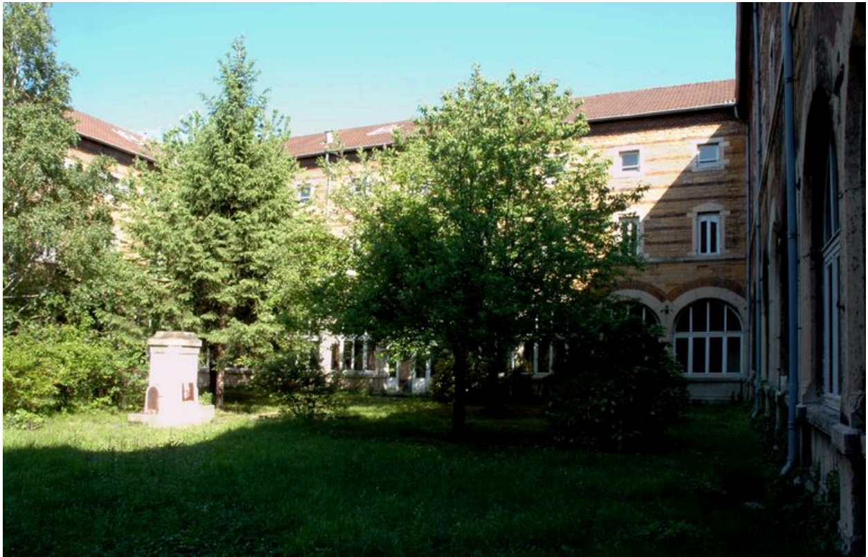
Cloître, élévation ouest
