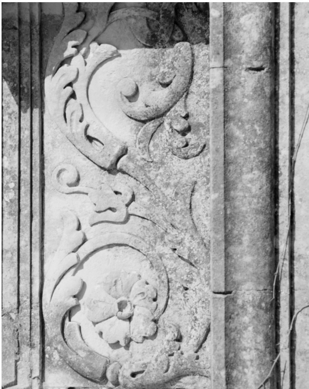
Cour du puits. Façade sud. Huitième travée de la frise sculptée.
