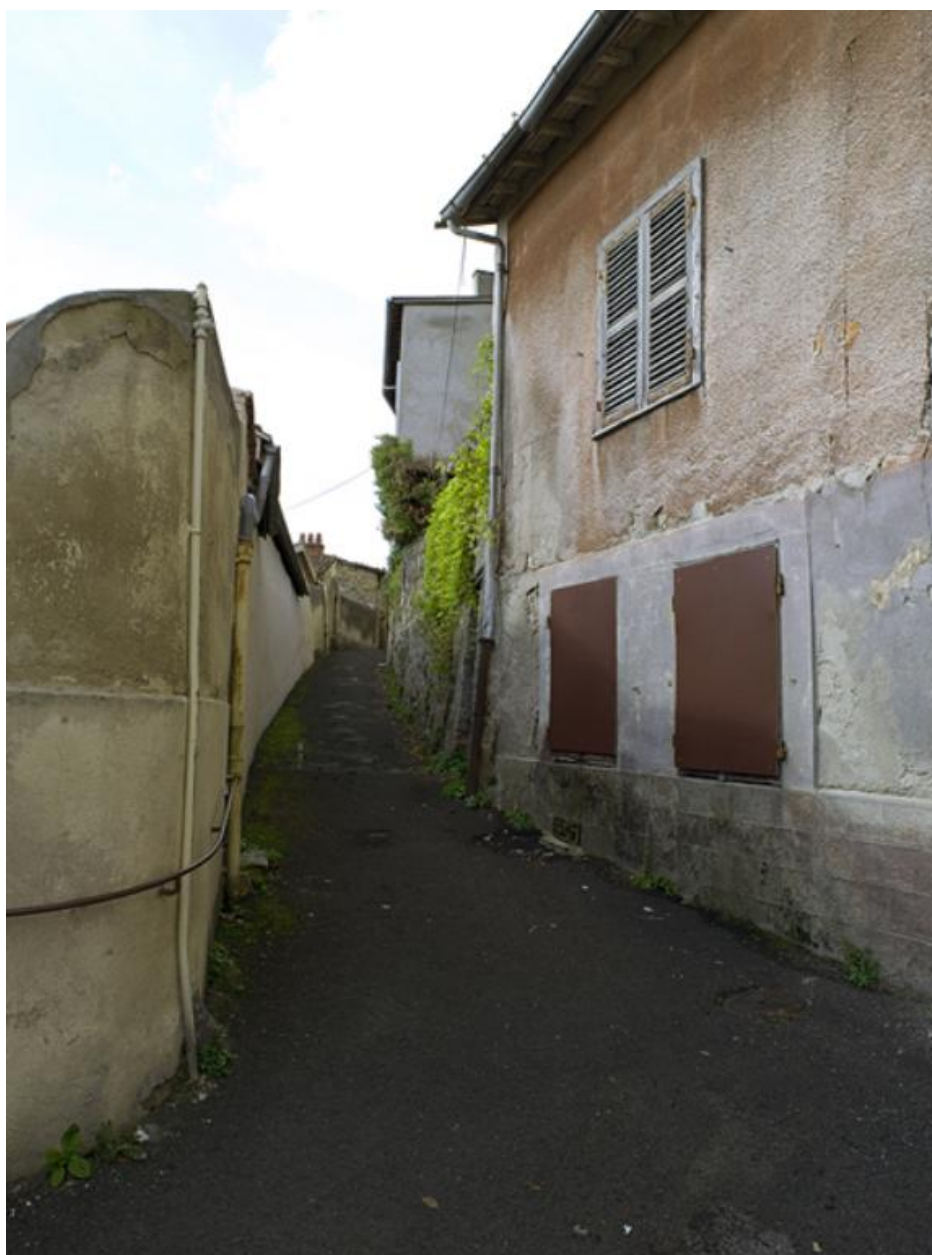
La rue avant travaux.
