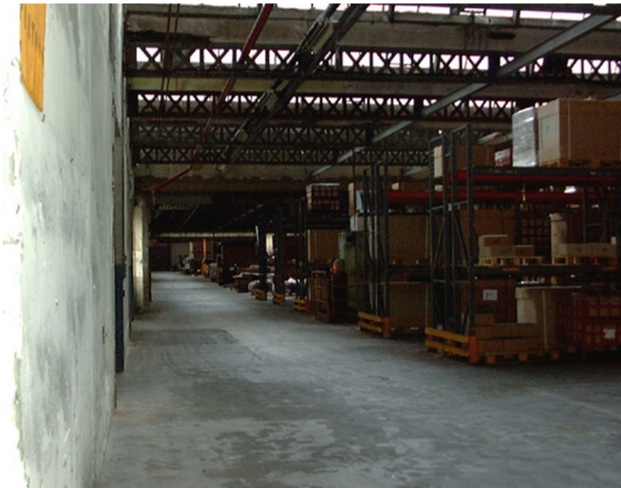
Magasin de stockage, travée de circulation
