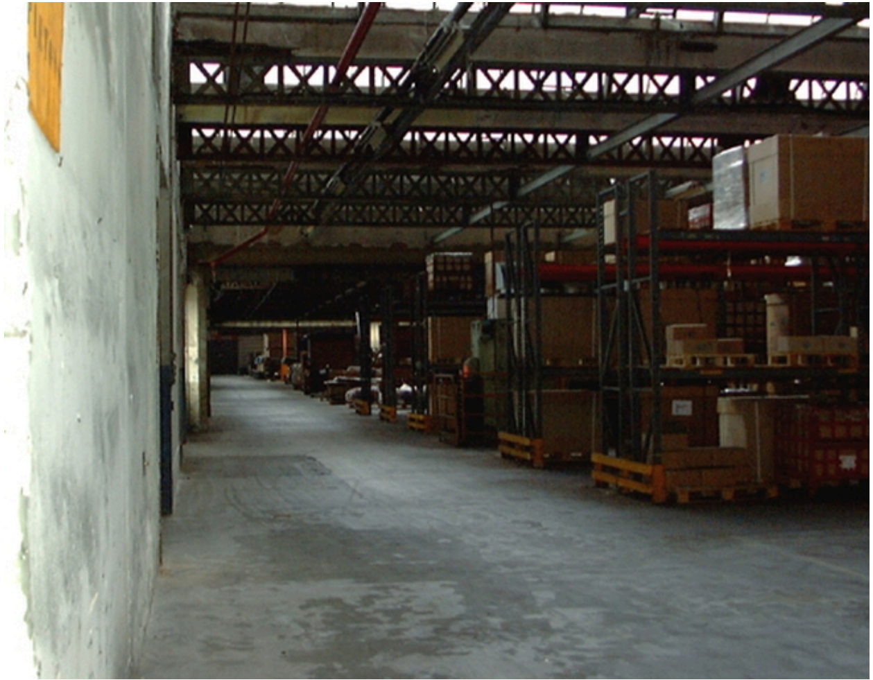
Magasin de stockage, travée de circulation
