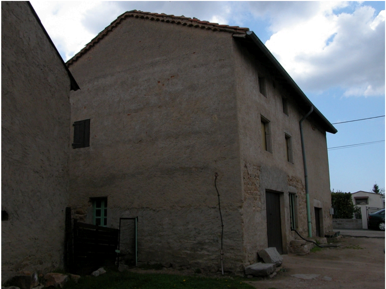
Vue d'ensemble du logis et étable, depuis le sud-ouest.
