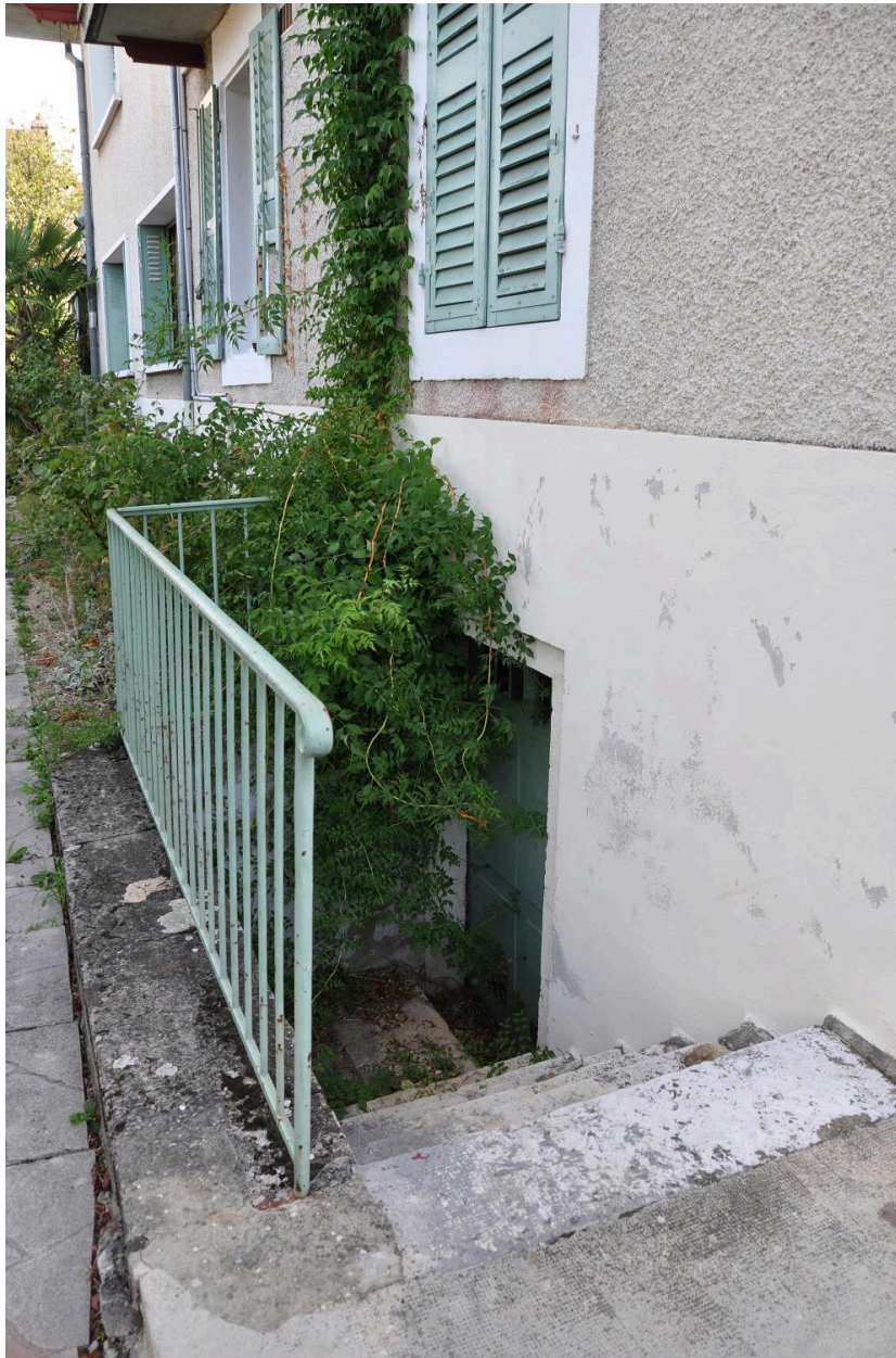
Descente de cave, à l'ouest
