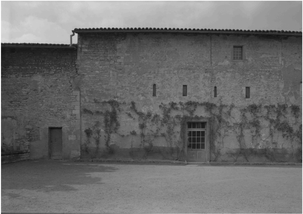
Aile gauche, détail d'élévation : baies de l'ancienne église.
