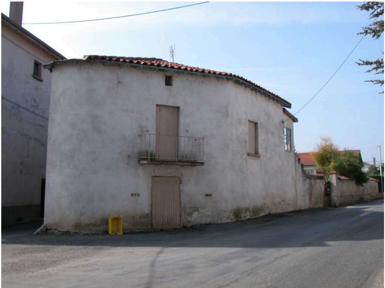
Purelles (les), ferme avec cuvage 1986 AL 40. Ferme avec cuvage et/ou cave, vue d'ensemble depuis la rue.
