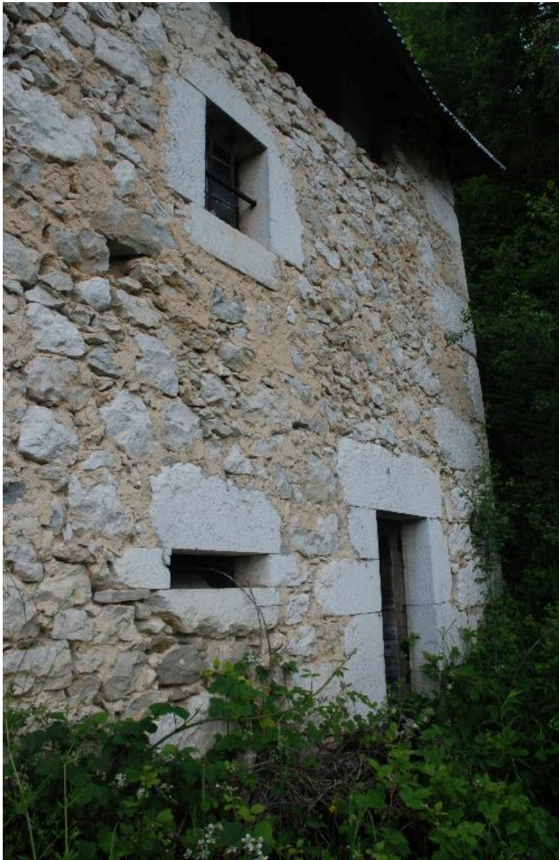
Vue de la façade latérale : entrée de la cave.
