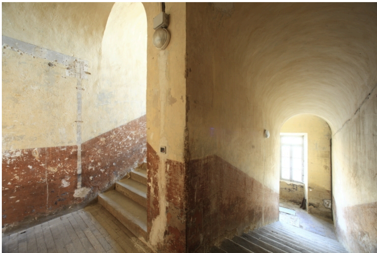
Bâtiment A. Escalier rampe sur rampe.
