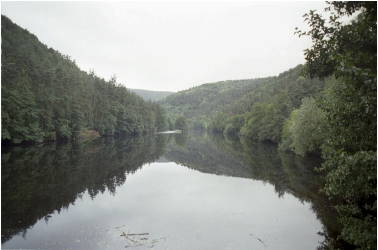
Barrage de la Beaume, vue d'ensemble de la retenue d'eau en amont.
