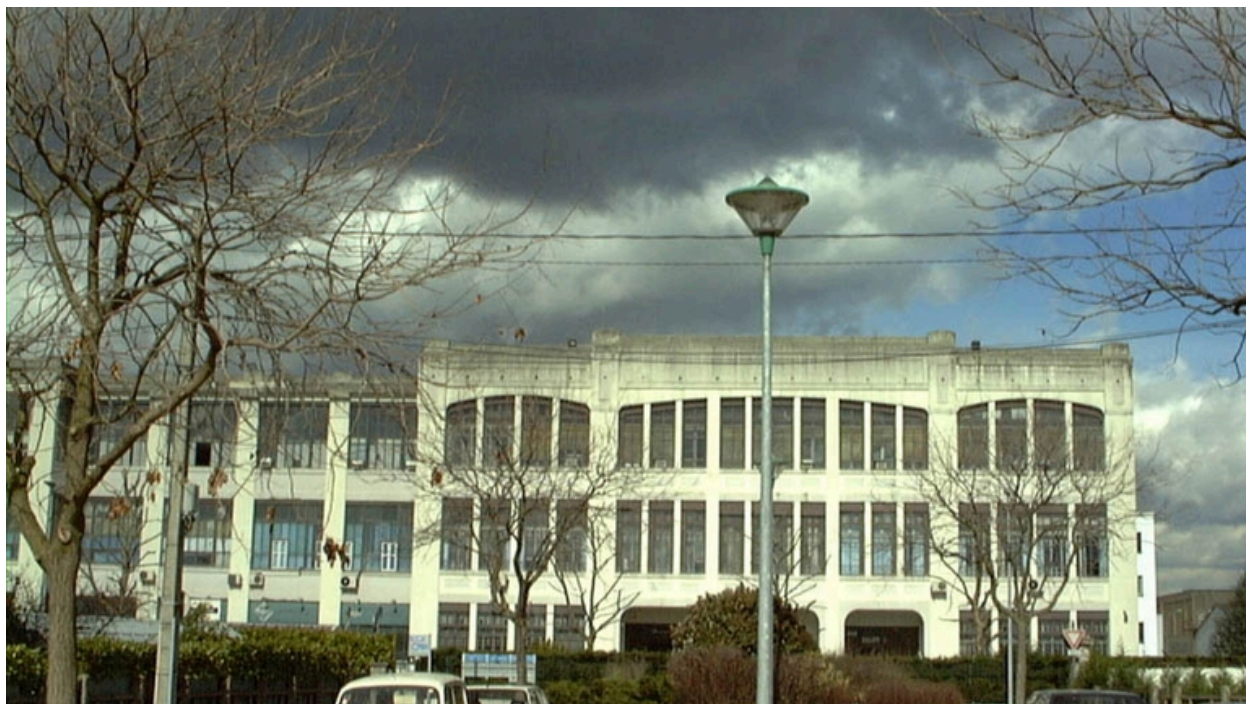
Vue d'ensemble sud du pavillon directorial
