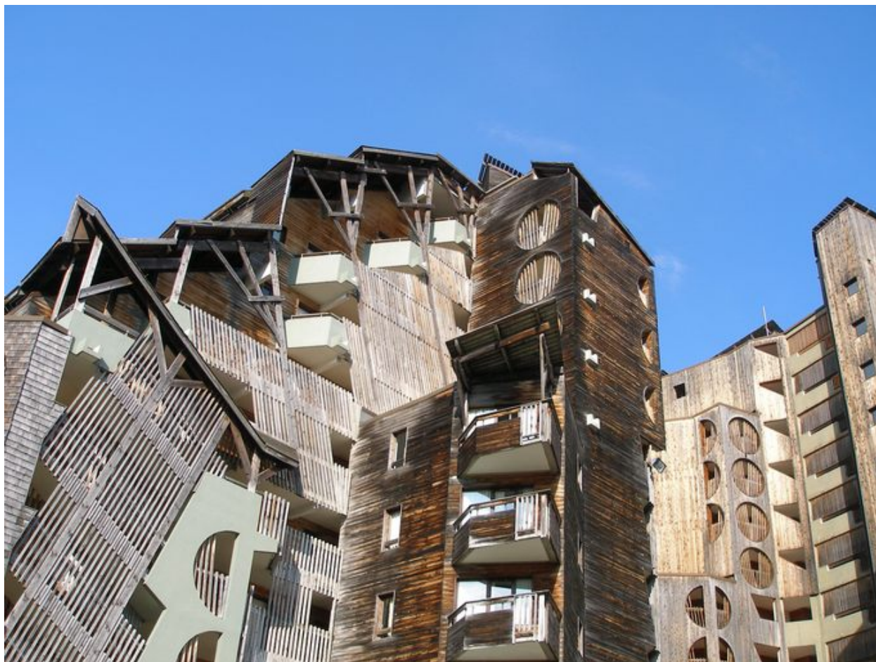
Façade nord. Vue des parties hautes
