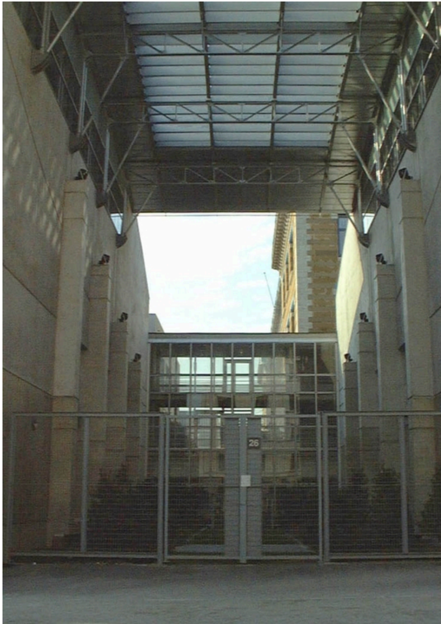
Détail entrée rue Rollet
