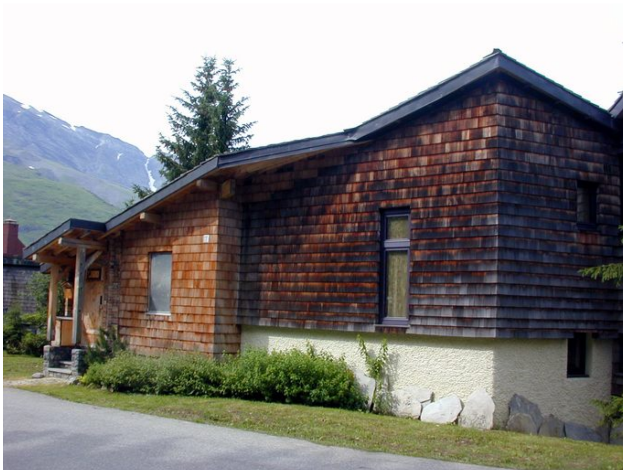
Elévation nord-est le long du chemin
