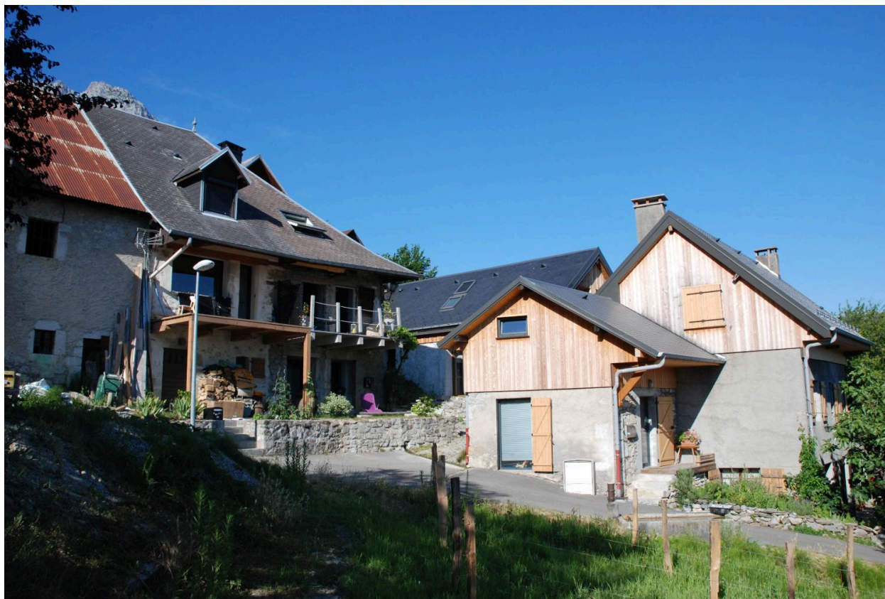
Impasse des Sartos, vue depuis l'ouest.
