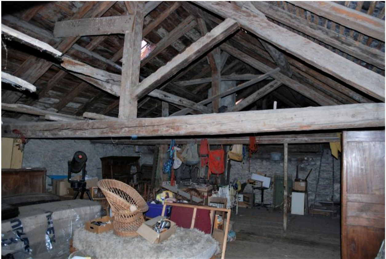
Etage de comble, vue en direction du nord, vue d'ensemble de la charpente.
