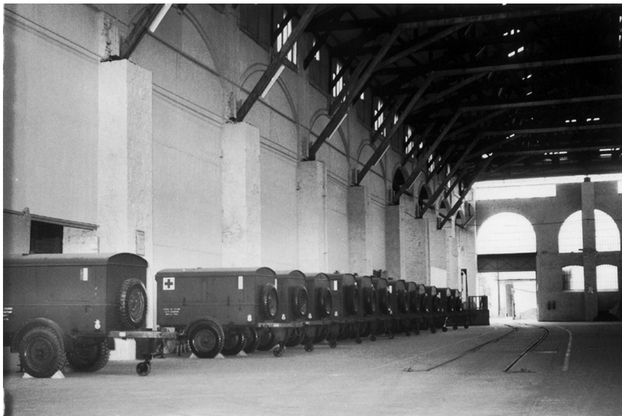
Vue intérieur de la halle, garage des ambulanciers, archives privées B. Jouve-Villard
